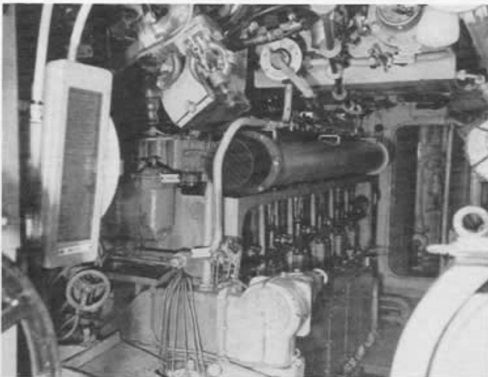
Dieselbe Blickrichtung wie beim oberen Bild mit nun eingebautem Dieselmotor.
