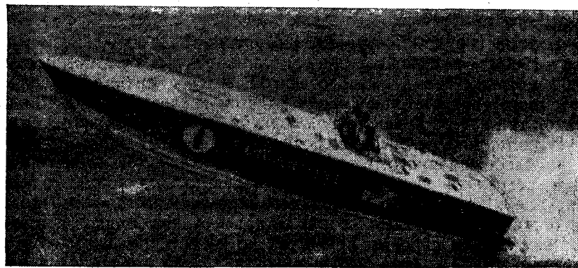
Рис. 125*. «Сигаретт». На этом катере американский гонщик Дон Ароноу победил в 1969 г. на первенстве мира по морским гонкам. Катер построен из стеклопластика фирмой «Кэри», имеет два двигателя мощностью по 475 л. с. с Z-образной передачей.
